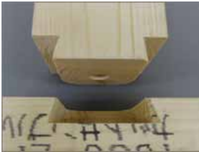
蟻仕口を採用している
