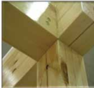
APS工法による組み付け部分
