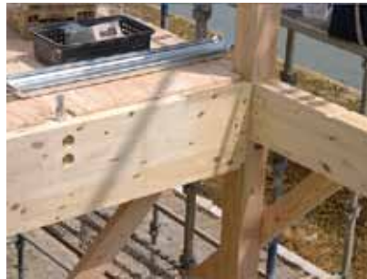
施工時に金物の出っ張りが生じない
