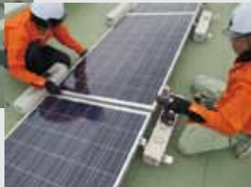
↓ただいま施工の真っ最中
