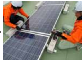
施工性アップ
