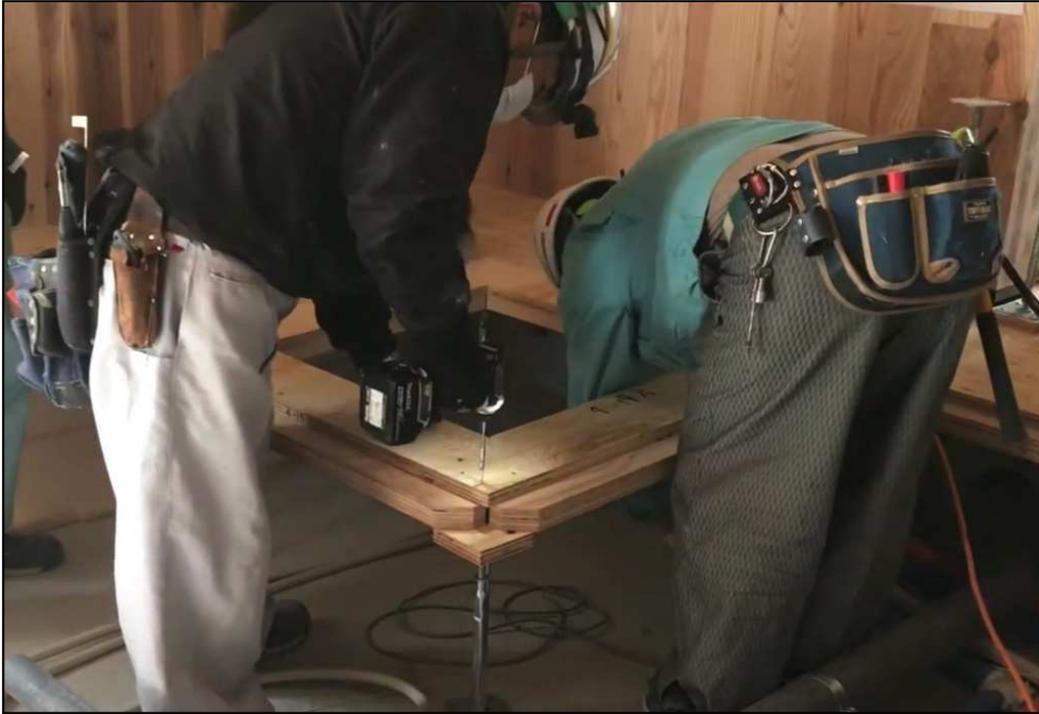
床下収納庫の設置位置にあたるパネルは、収納庫のサイズにパネルをくり抜いて納品します。
