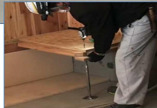
1タイプのコーナーパネルを際根太の上に乘せて設置し、角を専用鋼製束で受けます。
