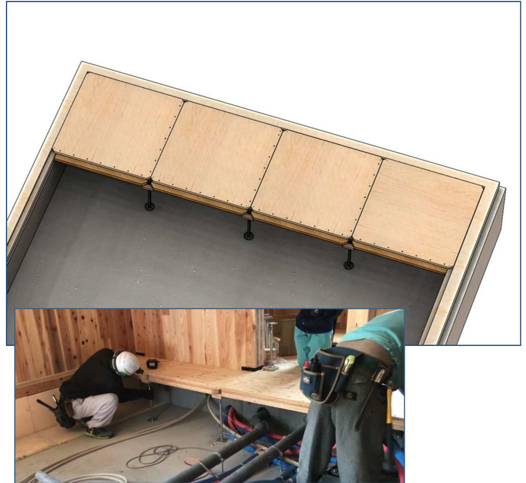
1列目の施工が完了したら水糸等で水平レベルを確認し鋼製束の高さを調整します。
